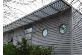
Bardage métallique panneaux sandwich
