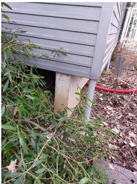
Figure 24 : Fourreau partant du vide sanitaire du bâtiment ACCUEIL vers le coffret BT sur rue (source : Antea Group)
