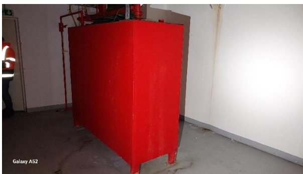
Sous-sol – Cuve glycolée et isolant en sous-face de la pièce
