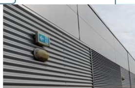
Bardage métallique ondulé
