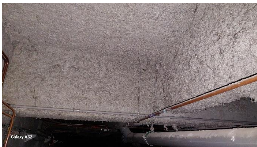
Figure 35 : Pour exemple, flocage en sous-face de plancher du RDC – Zootechnie A (source : Antea Group)
