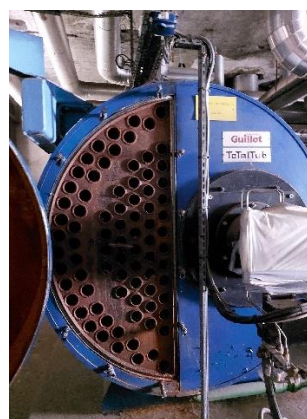
Vue intérieur- Installation technique : chaudières
