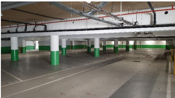
Sous-sol - Parking souterrain avec isolant en sous-face et divers réseaux
